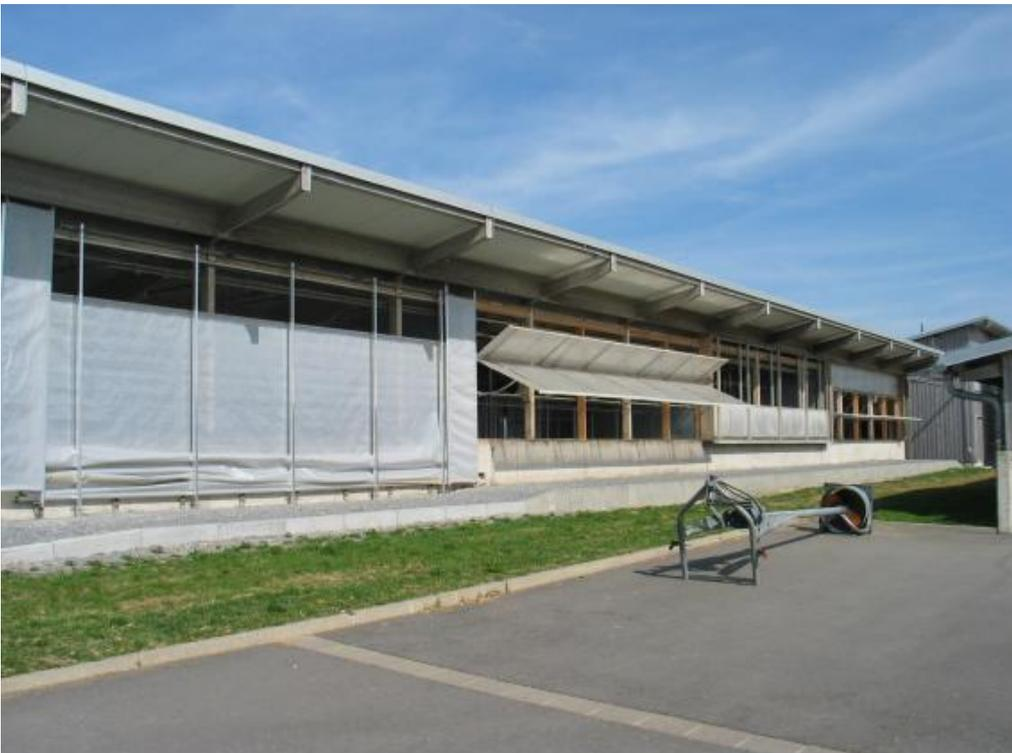
Bild 11: Frontöffnung in automatischer Lüftungsstellung (von oben öffnend)
