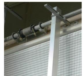
Bild 1 - 3: Wickelöffnung mit einer Gewebefolie und Hinterlagenetz, mittig wickelnd mit der Möglichkeit oben und unten zu öffnen im Abteil A
